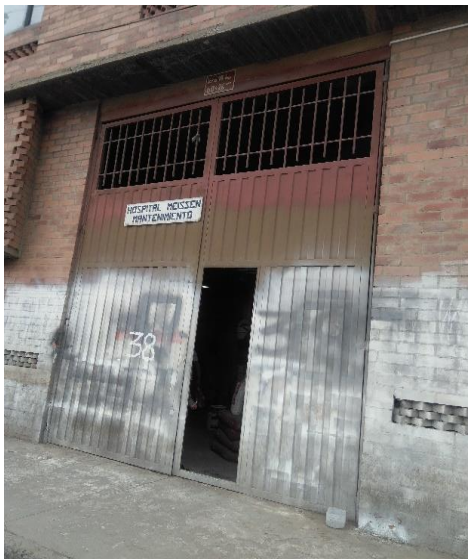
Fotografía 13. Fachada Área de Mantenimiento
